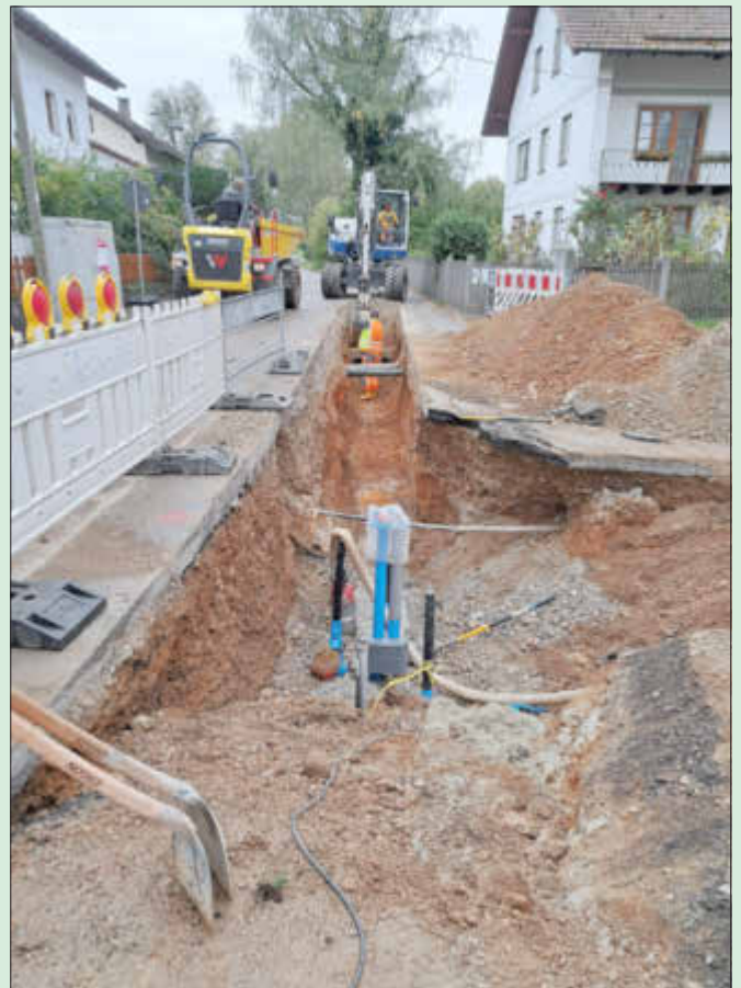
Hochwasserschutz und Wasserleitungsneubau Unterschwillach
