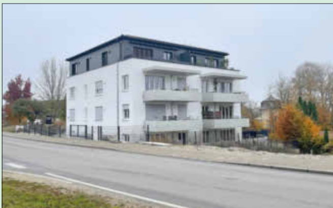
Mehrfamilienhaus Erdinger Straße Süd-Ost-Ansicht
